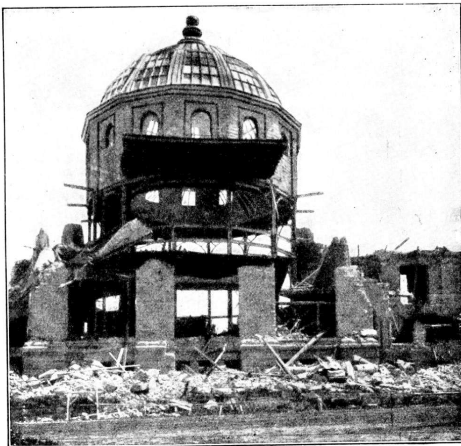
14: Fig. 14. — Universitetsbiblioteket vid Stanford University i Kalifornien efter jordbäfvningen 1906. Bilden visar järnkonstruktioners stora hållfasthet, jämförd med murverks. Jordbävningens inverkan på låga trähus synes på fig. 11.
